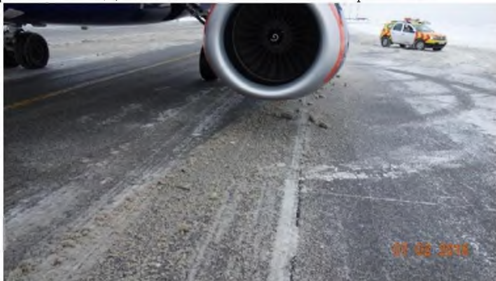
Пример некачественной очистки искусственных покрытий в аэропорту Шереметьево
